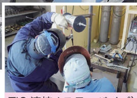
TIG溶接（ステンパイプ）
