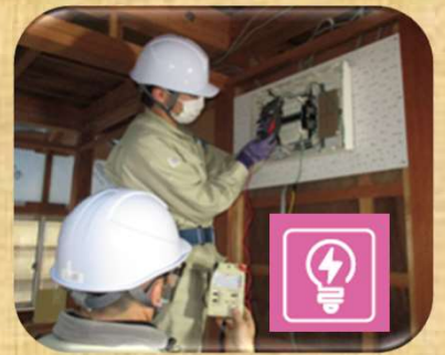
電気工事・設備科
